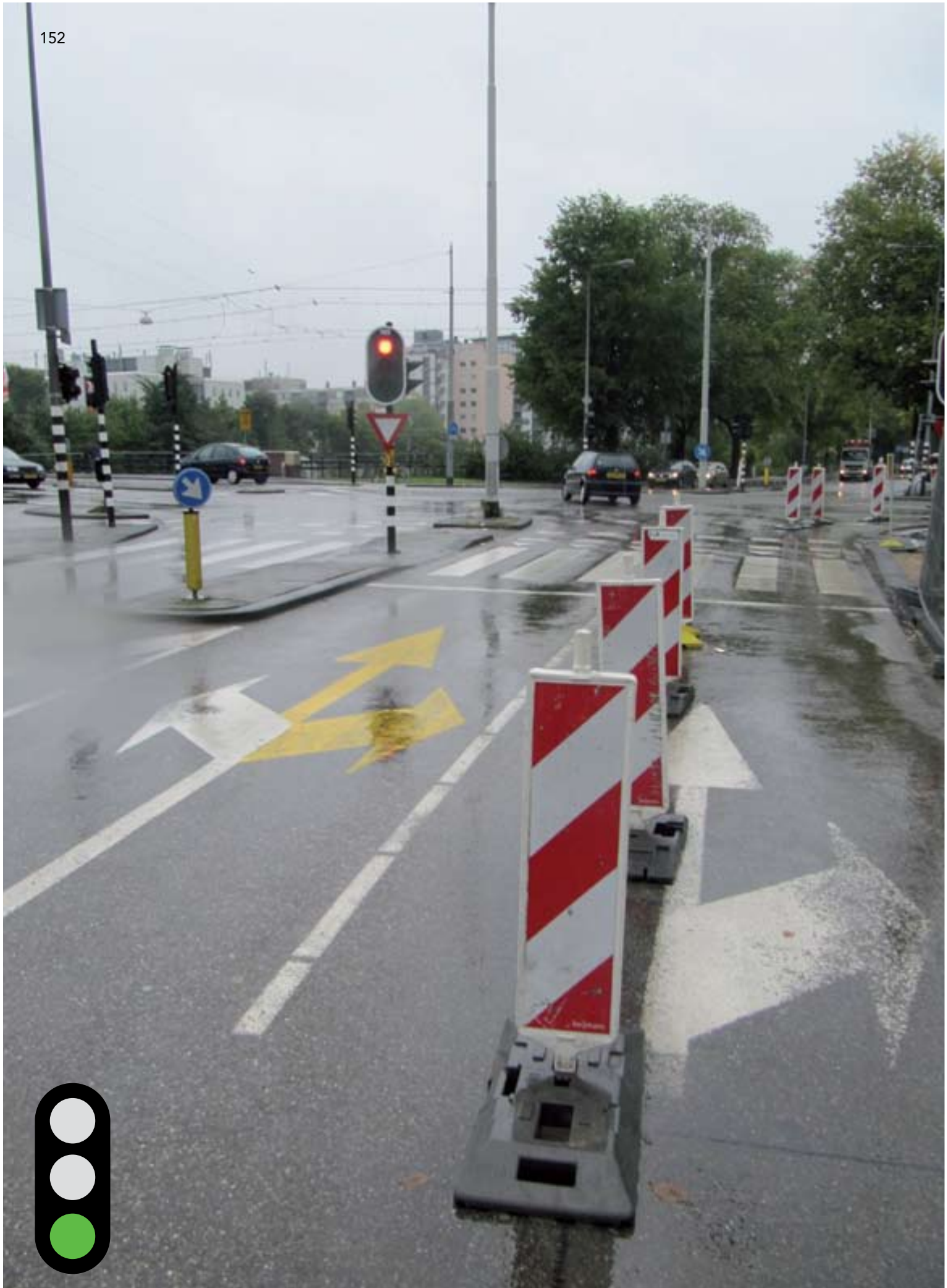
Goed aangebrachte tijdelijke belijning.
